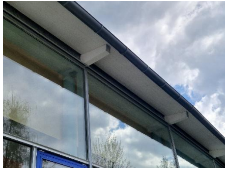
21. Nahaufnahmen älterer Gebäudeteil.
