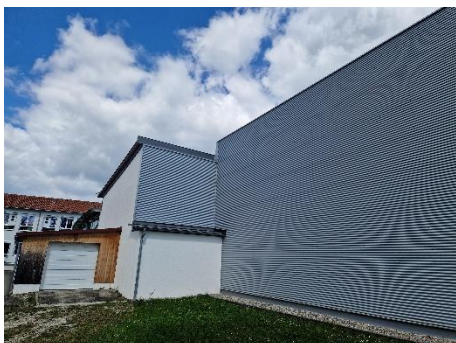
19. Blick auf neueren Gebäudeteil.
