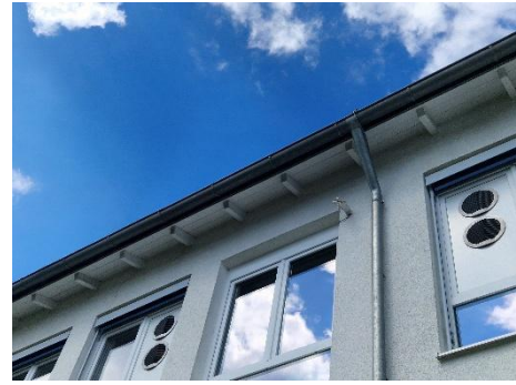
22. Nahaufnahme älterer Gebäudeteil.
