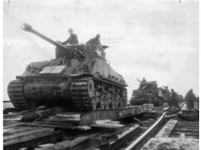
Panzer beim Überqueren der Kauferinger Eisenbahnbrücke. Zu sehen ist unter der Kette die Beschädigung der Brücke, hervorgerufen durch die fehlgeschlagene Sprengung deutscher Wehrmachtsangehöriger<sup>8</sup>
