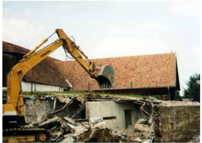
Beim Abriss der Hochfahrt bei der Hs.-Nr. 20 sind die betonierten Unterstellräume gut zu erkennen
