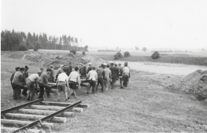
Mithilfe beim Verlegen der Laufschielen für den Eimerkettenbagger laden und zum Bleicher hinauffahren. Zu einer Bestrafung ist es dann nicht mehr gekommen.“
