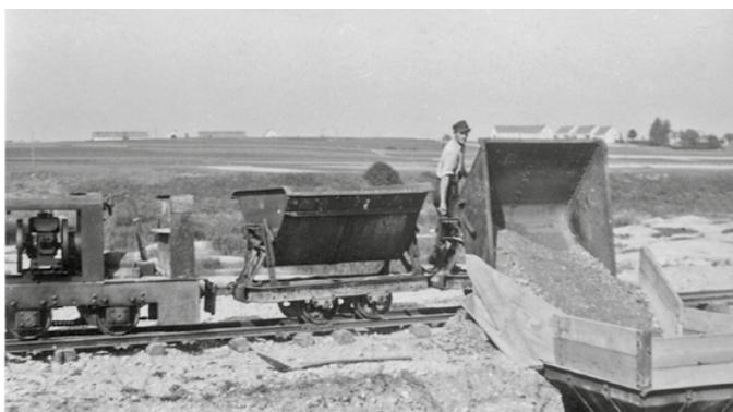
Das Material wurde mit einer Feldbahn zum Kieswerk transportiert
