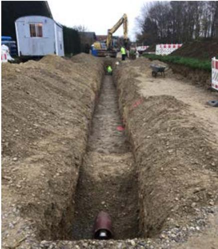
Zu den bereits abgeschlossenen Arbeiten gehört die Verlegung des Kanalsystems sowie die Installation von Revisionsschächten, die eine optimale Wartung und Kontrolle des Abwassersystems gewährleisten. Auch die Wasserleitung wurde vollständig verlegt, um die zukünftigen Bewohner mit frischem Trinkwasser zu versorgen.
