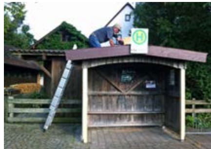
Das Bushäuschen vor und nach der Renovierung
