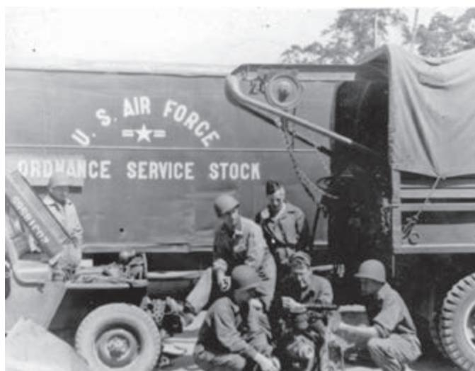
Zum Fuhrpark gehörte auch ein Abschlepptruck mit Kran und Seilwinde. Reparaturen wurden auf einem Parkplatz zeitnah ausgeführt.
