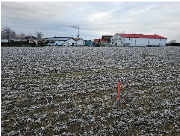
Messung des Bohransatzpunktes 3
