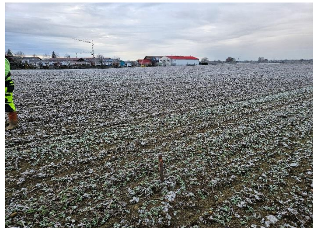
Messung des Bohransatzpunktes 4
