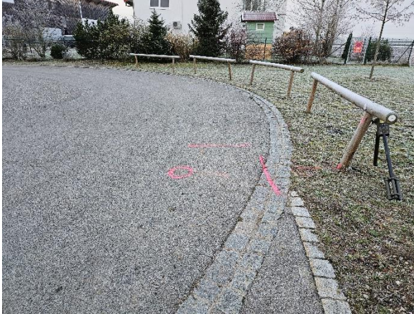
Messung des Bohransatzpunktes 1
