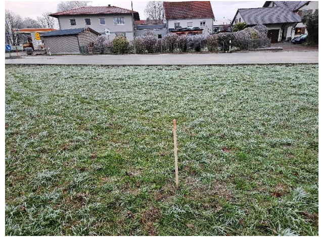
Messung des Bohransatzpunktes 8
