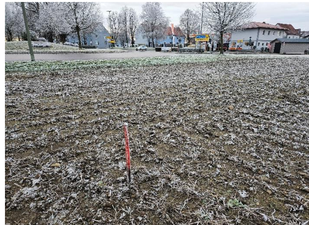
Messung des Bohransatzpunktes 6
