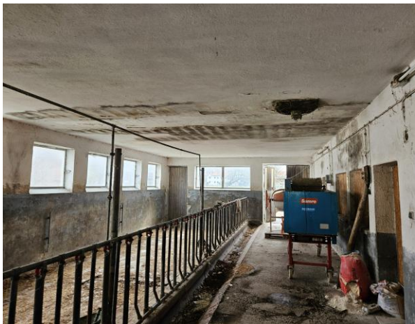
Abbildung 8: Innenansicht ungenutzter Stall
